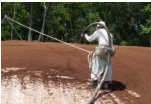
写真7. 法面マットフィルターの上面への 厚層基材吹付工の施工
