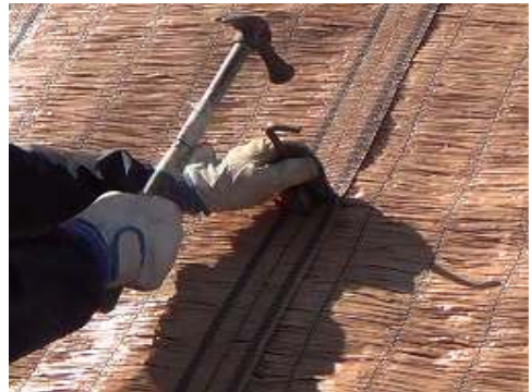
写真6. 固定アンカーの打設
