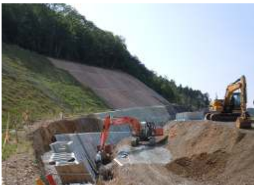
写真 1. 法面マットフィルターの施工後(中央)と大型ブロック擁壁の施工中(法尻)
