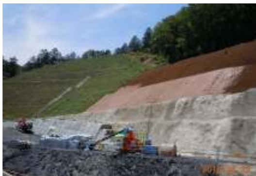
写真 2. 法面マットフィルターの上面に厚層基材吹付工を施工中(右上)とモルタル吹付法面、(左奥の法面は既設の緑化法面)
