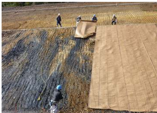
写真3. 法面マットフィルターの施工中
