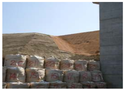
写真4. 雨水が集水する構造物周辺の盛土 法面への施工
